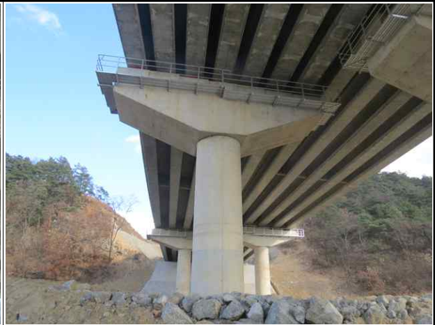
교각 P3(옥산방향) 전경
