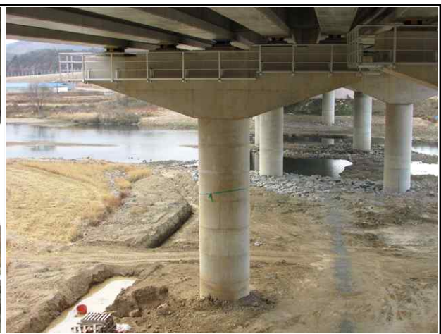
교각 P4(오창방향) 전경
