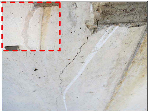
교각 P4(옥산방향) 균열(폭 0.3mm미만)(보수완료)
