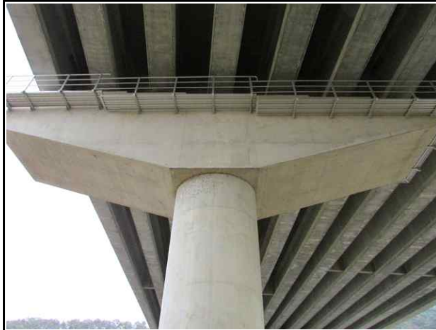
교각 P1(옥산방향) 전경
