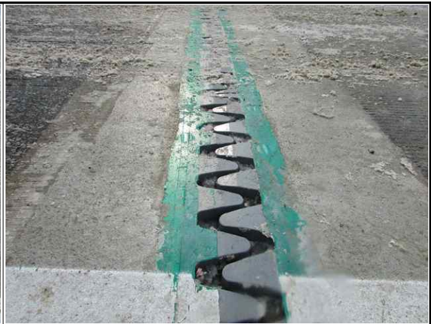
신축이음 상태양호(A2, 오창방향)
