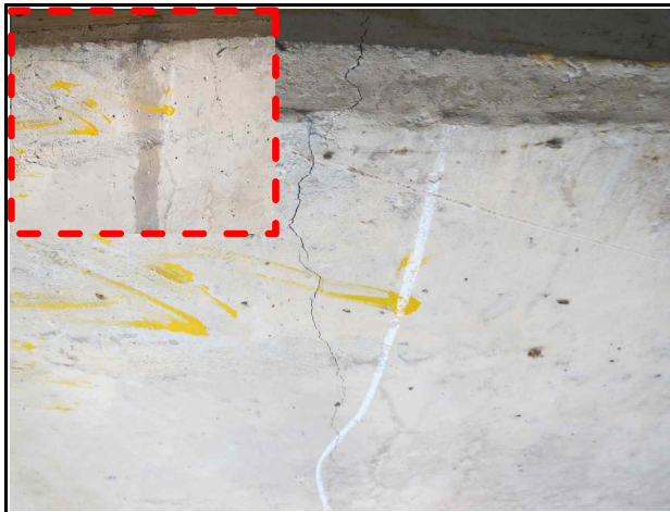
교각 P2(옥산방향) 균열(폭 0.3mm미만)(보수완료)
